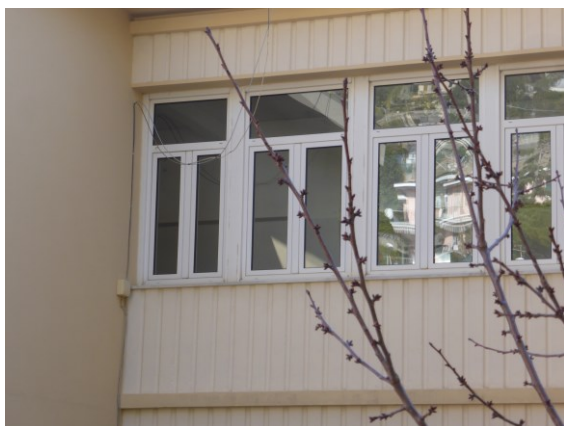
Figura 4.5 – Rilievo termografico dei serramenti tipo
