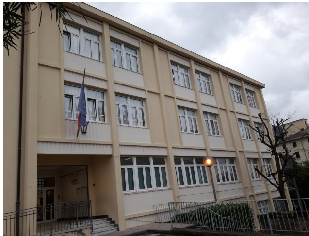
Figura 8.1 - Particolare della muratura esterna
