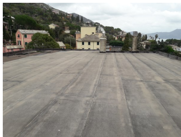
Figura 4.2 - Particolare della copertura piana sul solaio in latero-cemento
