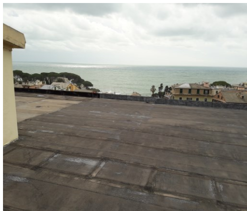
Figura 8.3 - Particolare della copertura
